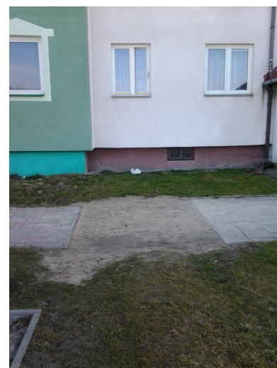
Fot. Zdjęcie przedstawia obszar obok bloku, który ma dwóch właścicieli i jak widać żaden z nich nie pokusił się o kupienie więcej kostki. Od razu zaręczam ten chodnik nie uległ zniszczeniu tylko wygląda tak od jego powstania!
